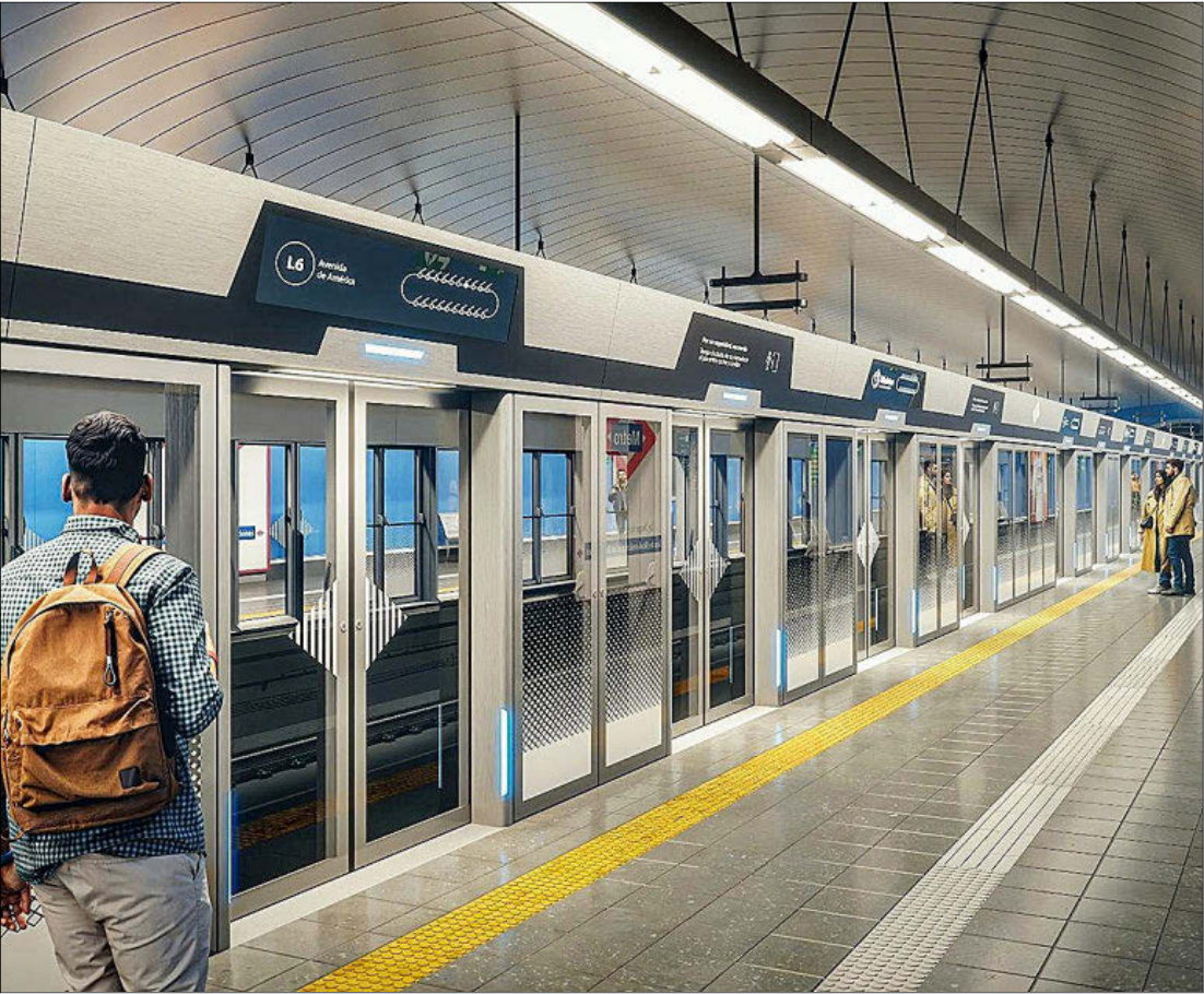
Recreación ilustrativa de los nuevos andenes de la Línea 6, con las mamparas de seguridad instaladas. E. M.
