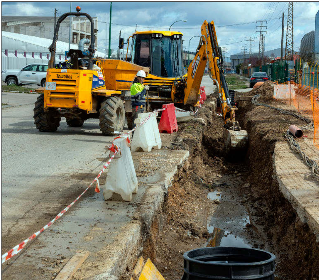
Unas obras de saneamiento de Aguas de Burgos, entre las más caras de la administración local. TOMÁS ALONSO
