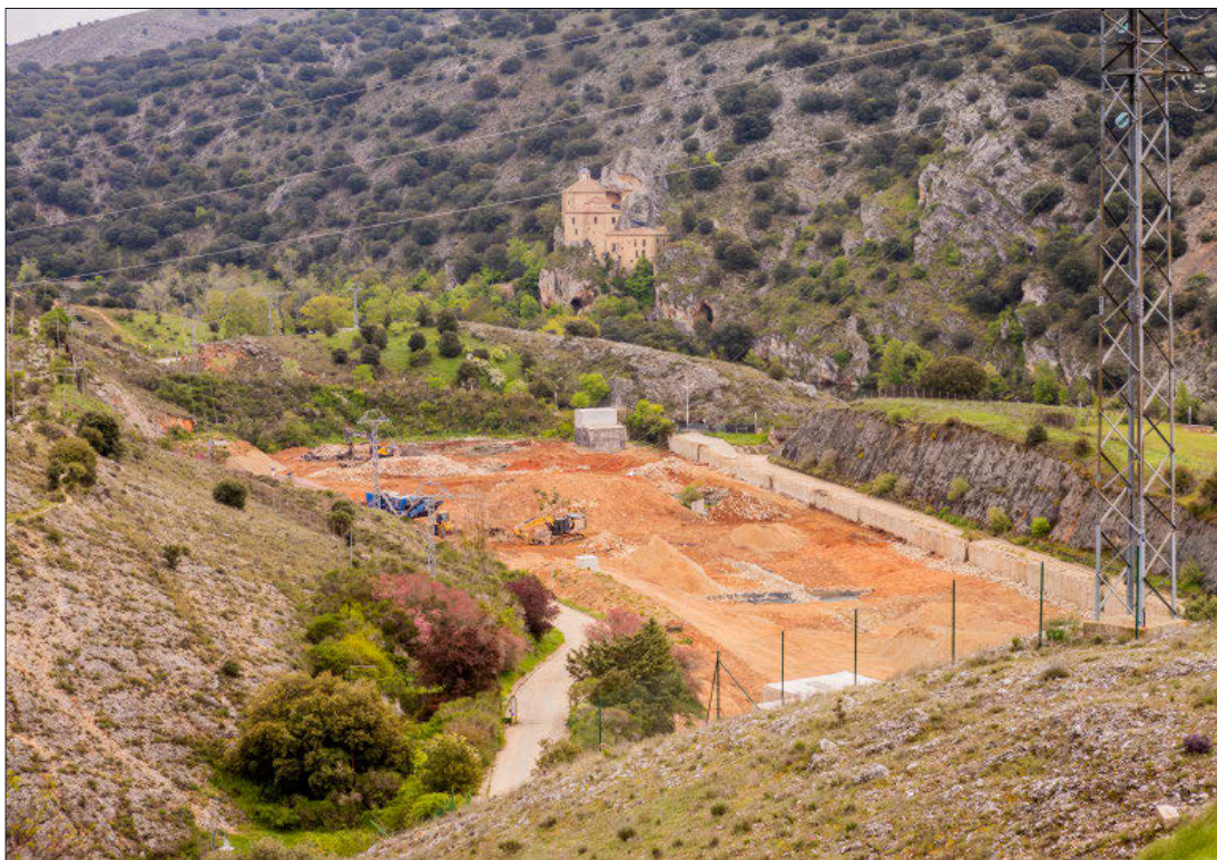
Estado actual de la parcela donde se ubicaba la antigua depuradora de Soria. MARIO TEJEDOR
